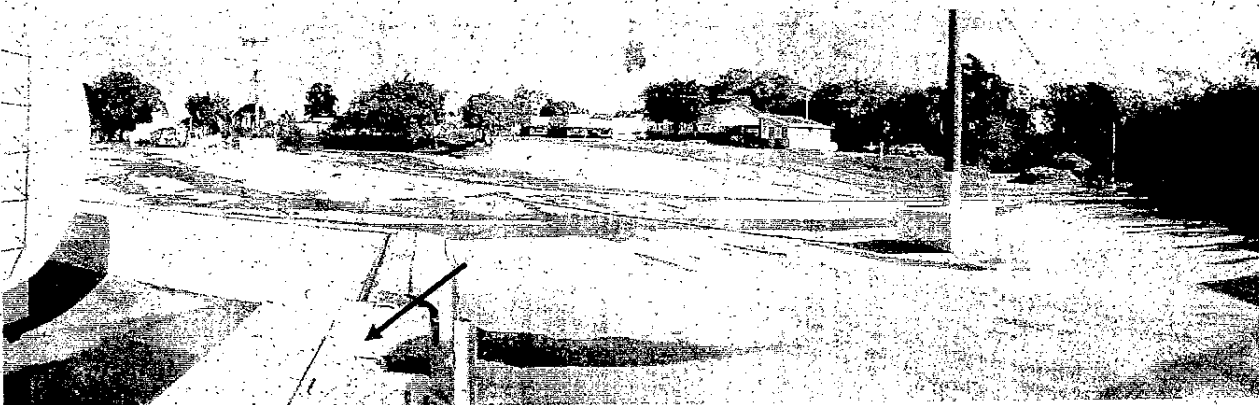
Foto 17: Pátio de entrada da empresa, asfaltado para diminuir a emissão de particulados no escritório. Setas indica SSAO da área de abastecimento.
